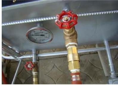
그림 2. 소독기 챔버 내부(증기 발생스팀관) 및 착탈식 고압증기호수, 연결밸브
