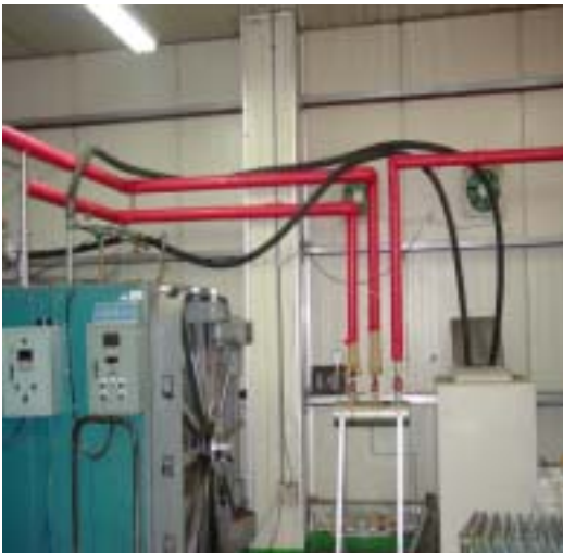
배기열 재활용을 위한 설치 광경
